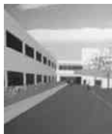
Futuras instalações da FCS
